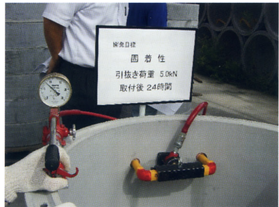
写真-3 引抜き試験状況
