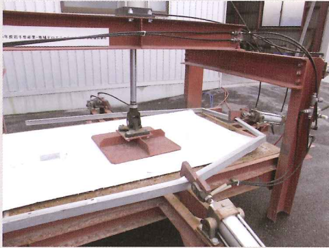
アルミ解体機でアルミ枠を外す
